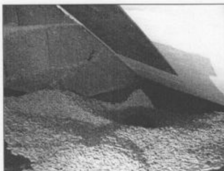
Abb. 1: Lagerraum mit Schüttrohr
